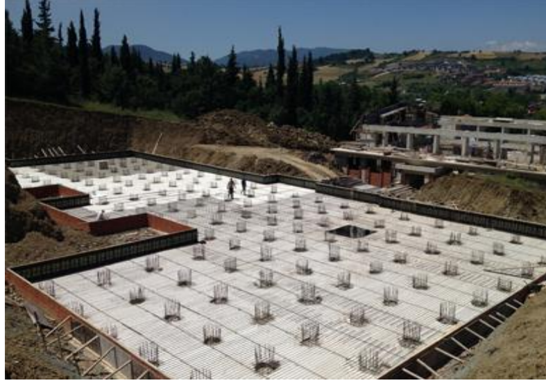
Şekil 4.21. Kazık grubu uygulaması.
