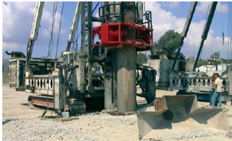
Şekil 2.6. Taş kolon uygulaması (Nalçakan, 2004).
