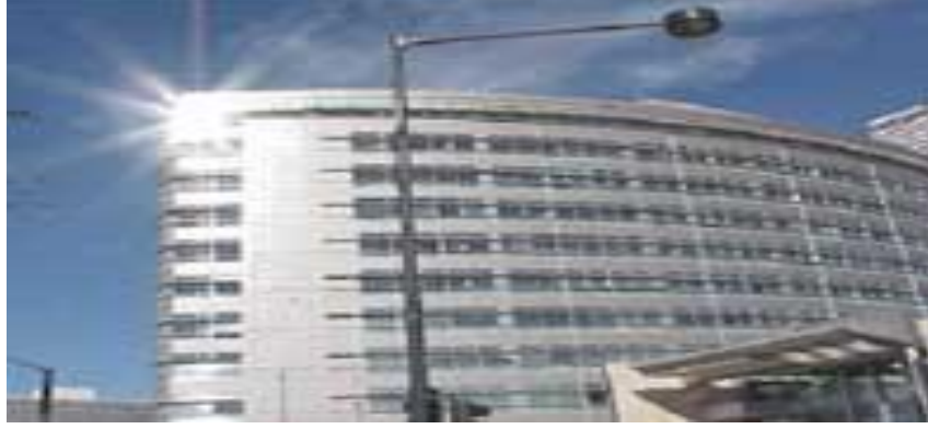
Şekil 1.14. Genleşmiş Kil ile Yapılmış Hafif Beton Kullanılmış Bir Yapı
