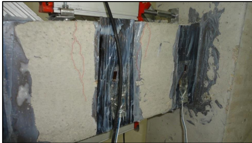
Şekil 4.10. S1 deney elemanında meydana gelen çatlak gelişimi.
