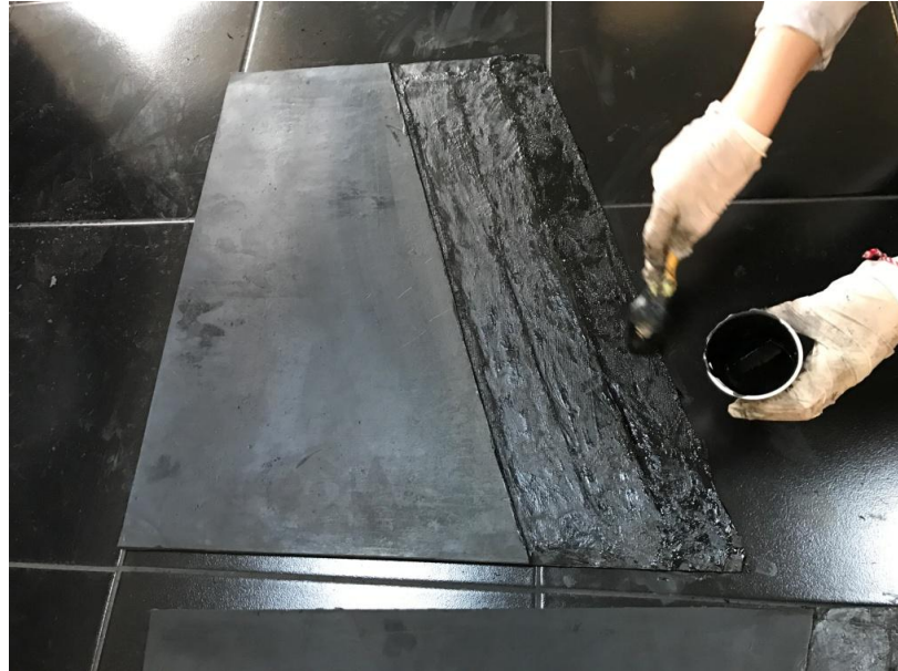
Şekil 7.25. Soğuk vulkanize yapıştırıcının konveyör bantlara uygulanması.
