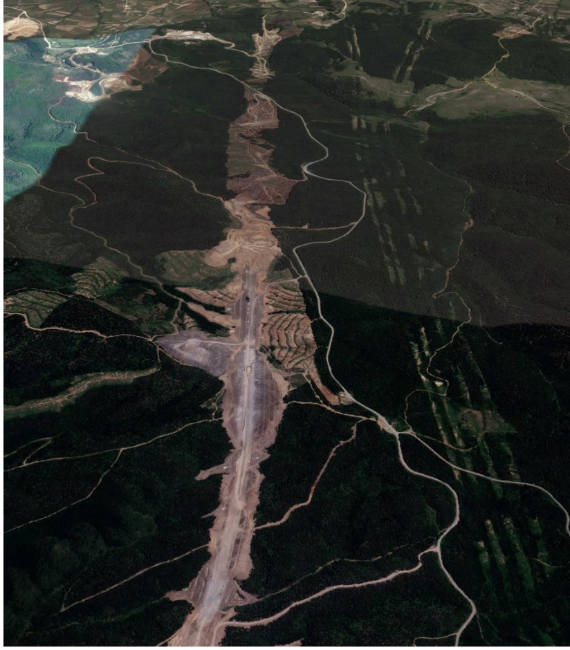
Şekil 18: Kuzey Marmara Otoyol Çalışmasından Kaynaklanan Tahribat (Google Earth 16.06.2018)
