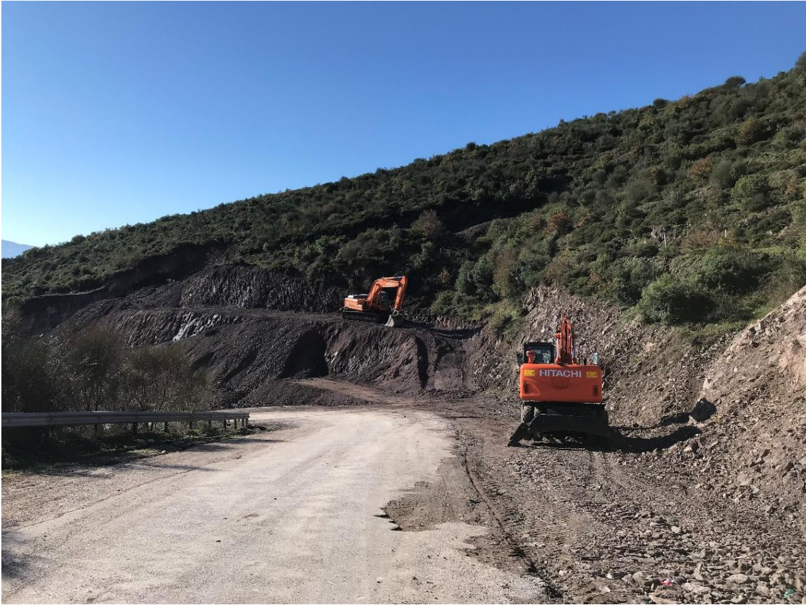
Şekil 17: Hacı Osman Mahallesi Kuzeyinde Yol Genişletme Çalışması (25.12.2017)
