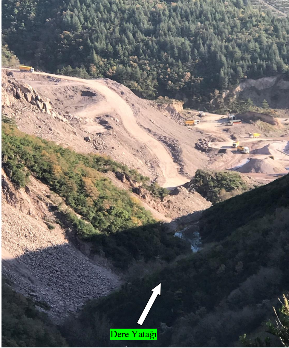
Şekil 14: Yavuz Sultan Selim Mahallesiindeki Taş Ocağında Gerçekleşen Kayma (15.12.2017)
