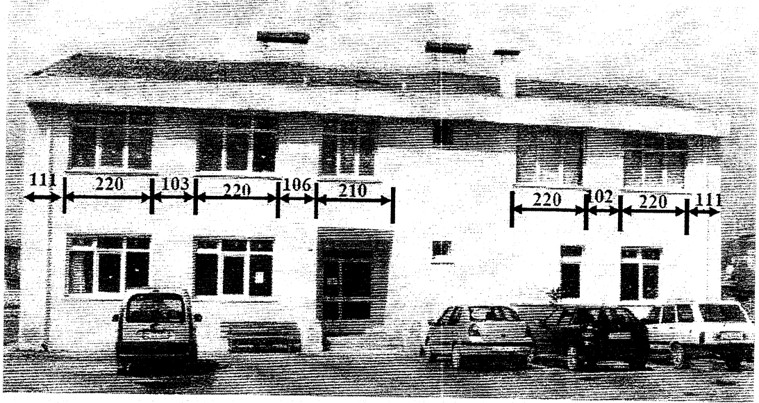
Şekil 15. Çivril Lisesi - yapının ön cephesinde kapı ve pencere boşlukları
