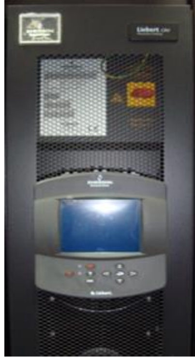
Şekil 3.23. İklimlendirme sistemi iç ünitesi(in-row).
