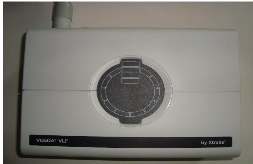
Şekil 3.39. Çok erken aktif duman algılama sistemi ana ünitesi.
