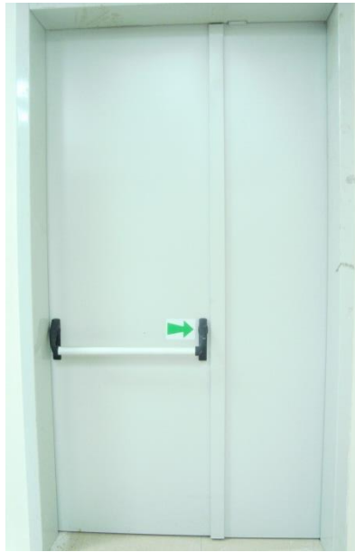
Şekil 3.7. Veri merkezinde kullanılan 140 cm x 250 cm yangın kapısı.
