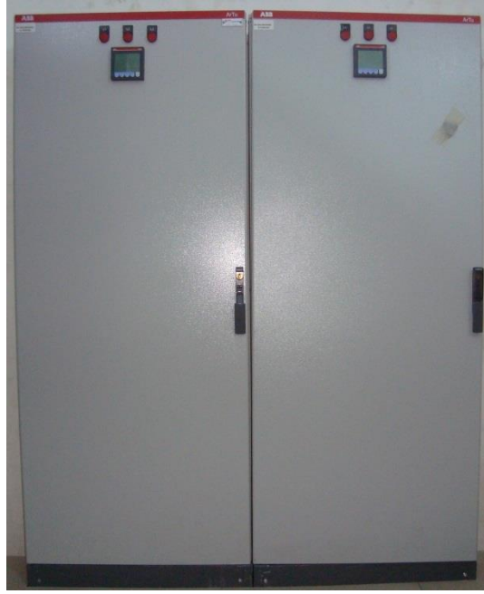
Şekil 3.18. Veri merkezi iklimlendirme panoları.
