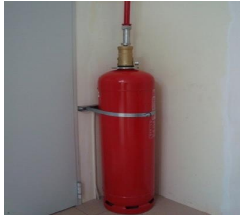
Şekil 3.37. Yangın söndürme sistemi tüpleri.
