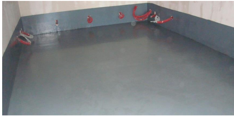
Şekil 3.6. Epoksi boya uygulaması.
